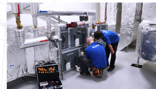
Elektroinstalace, Měření a regulace
